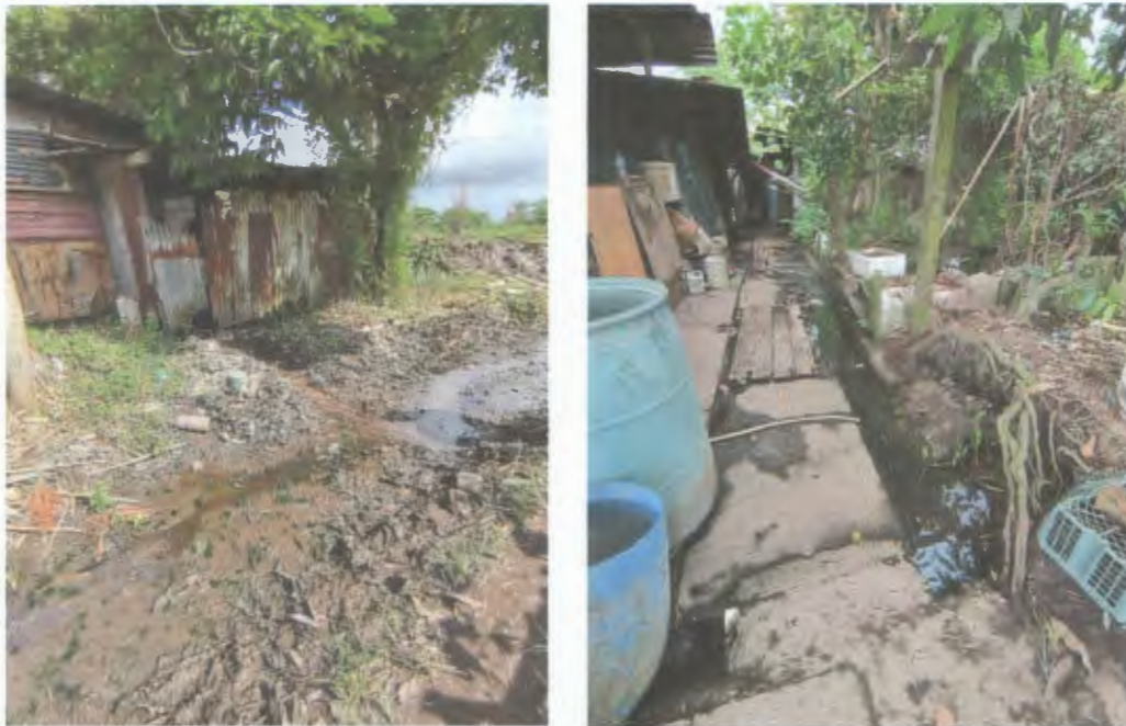
Gambar 4. Sistem pembentungan saluran najis yang tidak teratur
